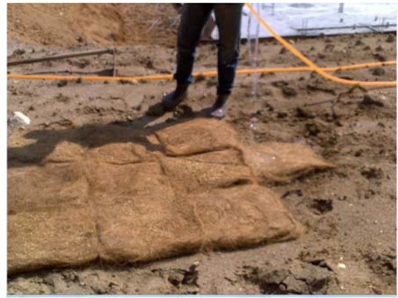
gambar 13 : Proses menyiram pallet yang telah disusun
