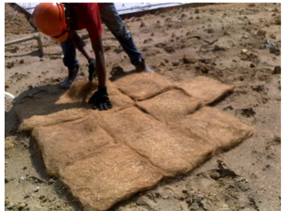
Gambar 12 : Proses meletakkan dan menyusun pallet
