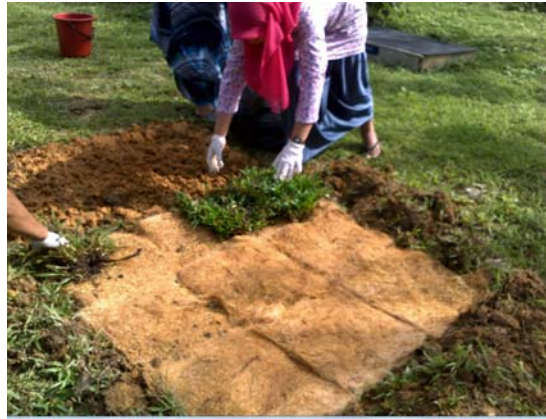
Gambar 10 : Proses meletakkan dan menyusun rumput
