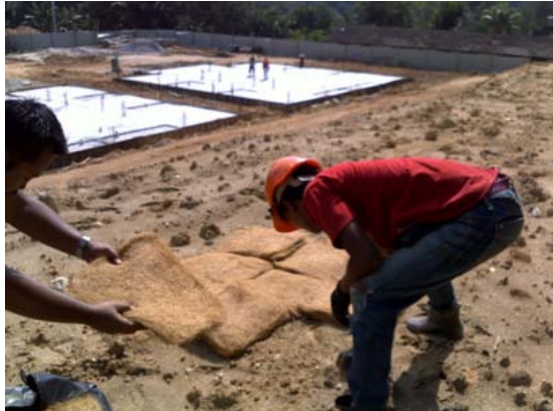
Gambar 12 : Proses meletakkan dan menyusun pallet
