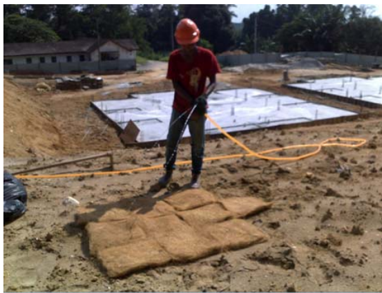
gambar 13 : Proses menyiram pallet yang telah disusun
